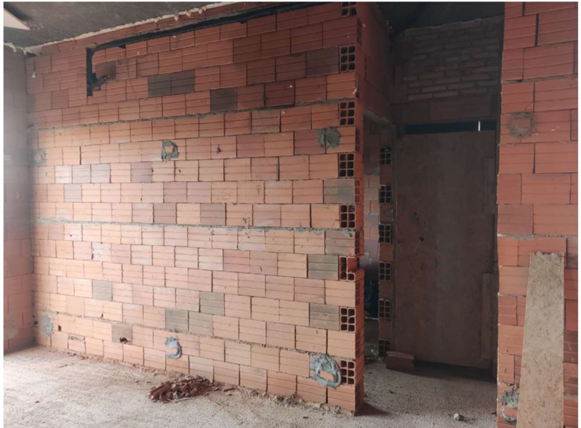
Avance de albañilería en N1
